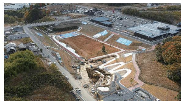
▲ 着々と工事が進む神楽沢近隣公園
