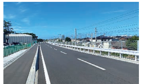
▲ 要望③ 結川町地内道路の整備(完成)
