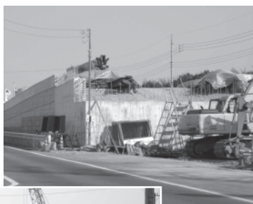
高架橋工事の様子
