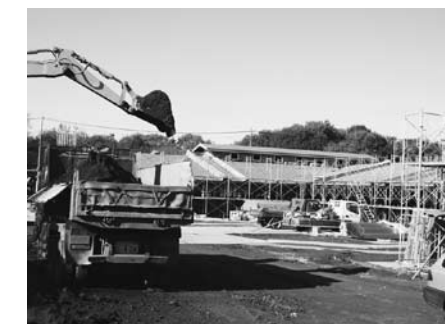
急ピツチで進められる保育所の工事
