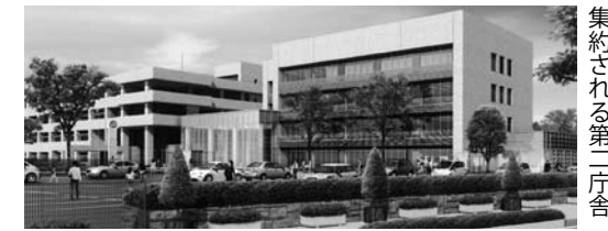
本庁舎として機能が集約される第二庁舎
