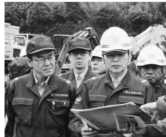
復旧状況について確認する
