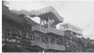
津波避難階段（旭町）
