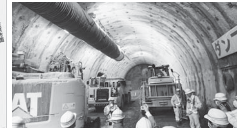
羽根トンネル工事視察
