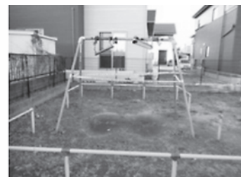
▲公園遊具の破損
