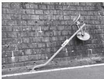
▲カーブミラーの損傷
