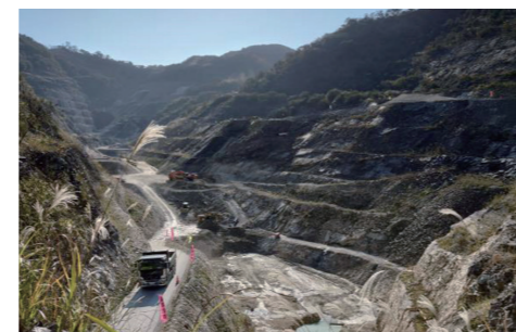
▲北側区画 敷地造成工事 (R6.11.14撮影)
